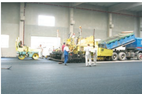
ATG Einbau, Unterstützung durch Contec
