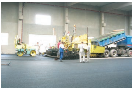
ATG Einbau, Unterstützung durch Contec
