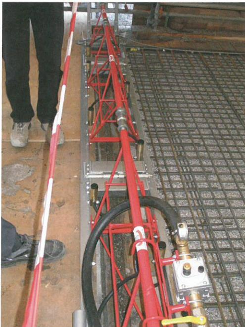
**Bild 3** Rüttelbohle vor Betonage
