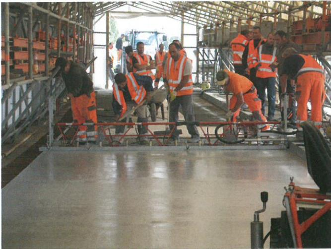
Bild 5 Einbau des UHPC
