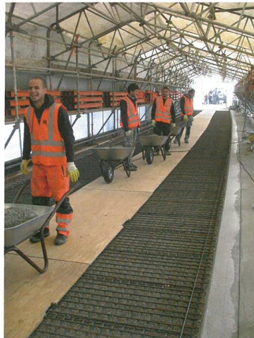
**Bild 4** Anlieferung des UHPC
