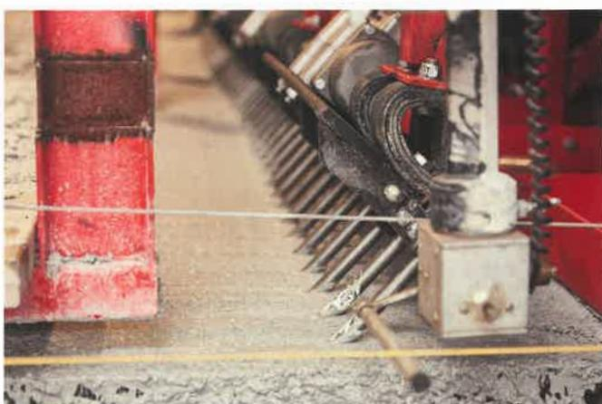
**Bild 7** Detailaufnahme der Rüttelfinger des Einbau-fertigers im hochfesten Beton
