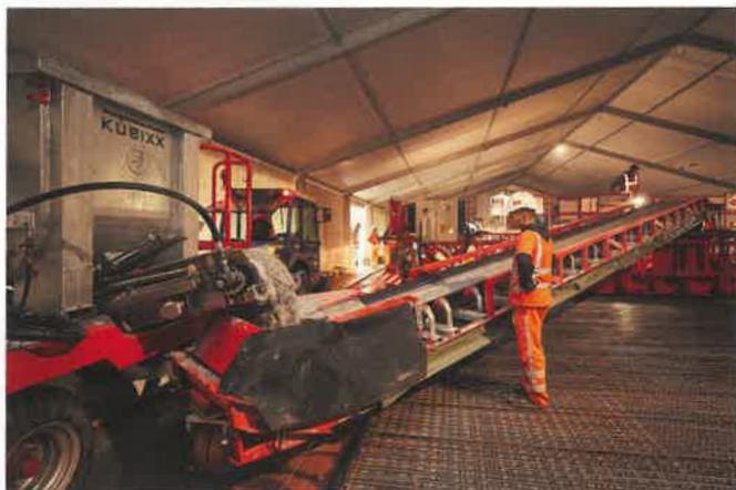
**Bild 6** Übergabe des Betons aus Kubixx an das Förderband des Einbau-fertigers
