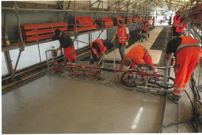
**Bild 2** Händische Betonage mit Rüttelbohle unter Schutzzelt beim Pilotprojekt Beimerstetten
